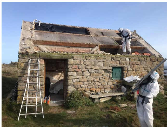
Enlèvement de la toiture en fibrociment amianté © Louis Dutouquet / HELP SARL
