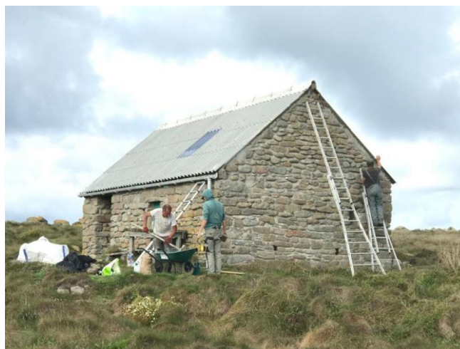
Reprise de l'étanchéité des pignons © Louis Dutouquet / HELP SARL
