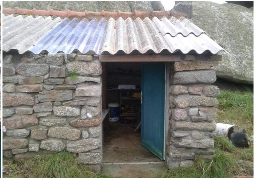
Toiture remise en état suite au passage de la tempête Ciaran © Armel Bonneron / OFB
