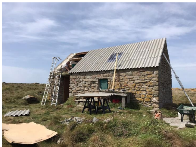
Pose de la nouvelle toiture © Louis Dutouquet / HELP SARL
